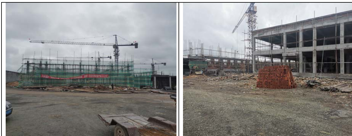
生产加工车间建设现状照片
