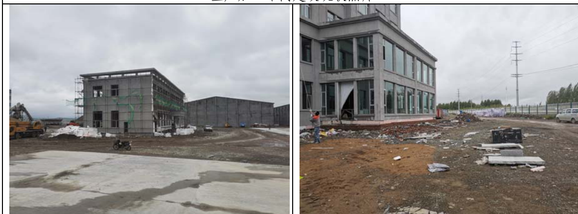
办公楼建设现状
