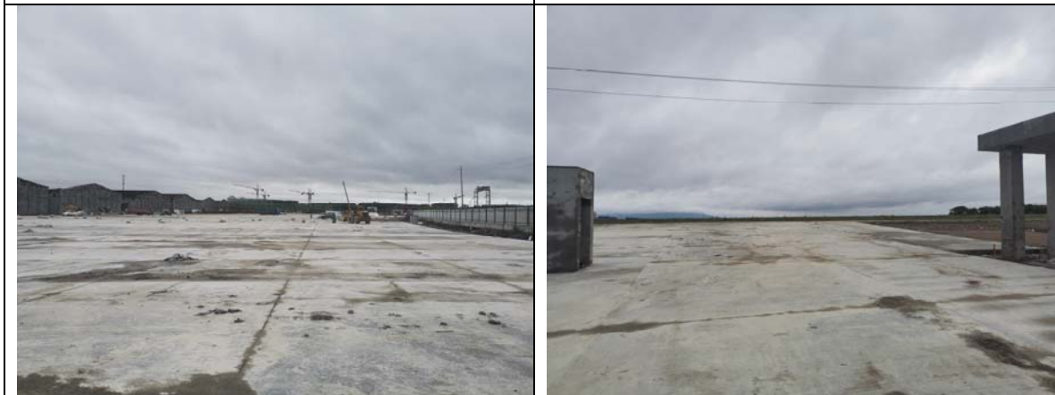
粮食堆场硬化区现状
